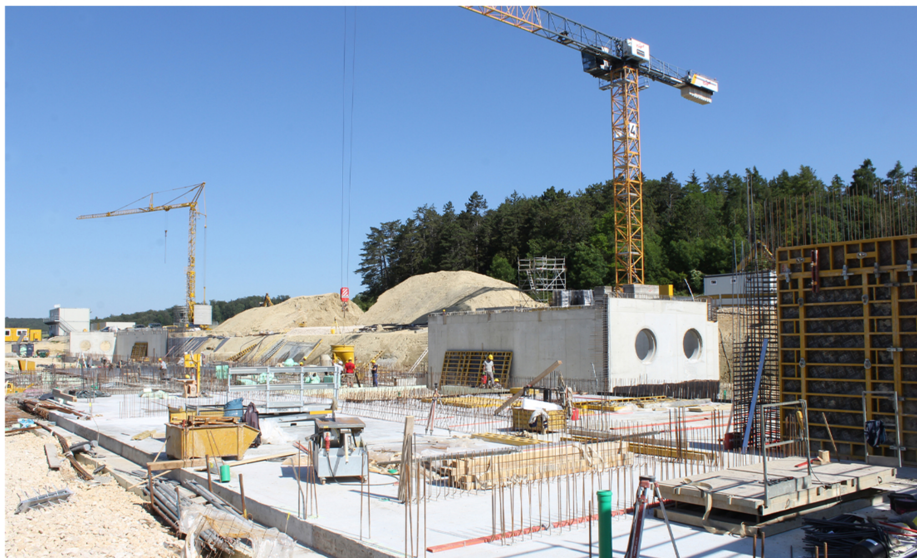
In Sigmaringen entsteht zurzeit ein moderner Neubau für alle Berufsschulbereiche der dort ansässigen Bertha-Benz-Schule. FOTO: OEST
